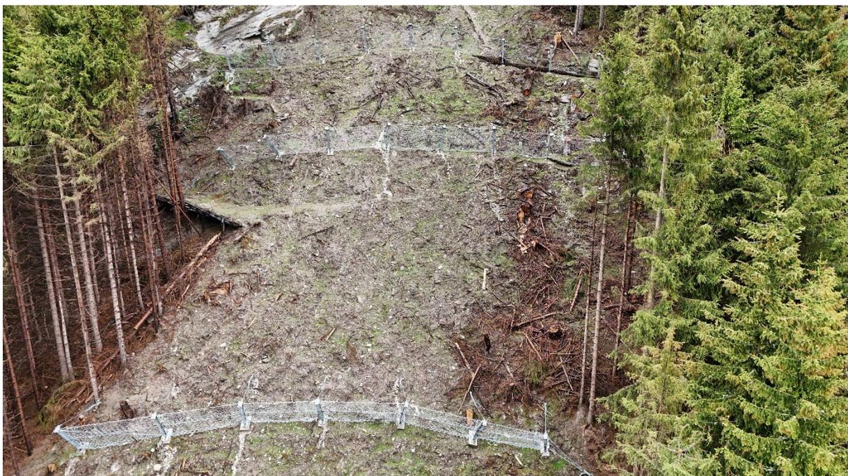
Abb. 30: fertiggestellte Lawinenschutznetze im Bereich der beräumten Rinne
