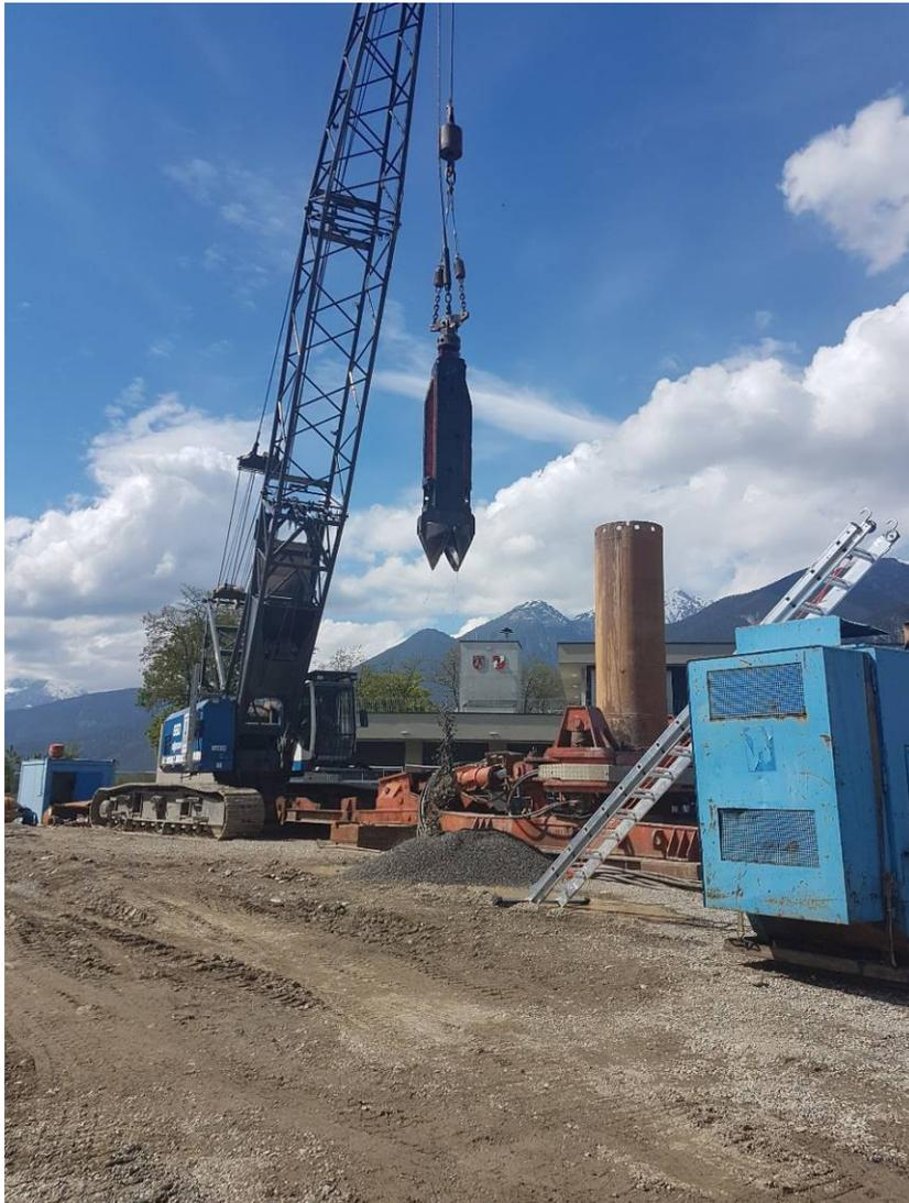
**Greiferbohranlage (von 49 bis 112 m uGOK)**
