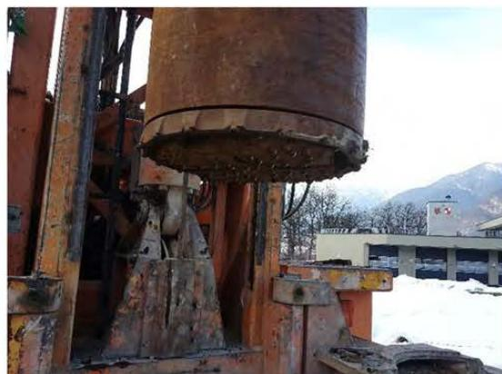
Weiterentwickeltes Rammkernverfahren mit Spülung und Doppelkernrohr (© Geomechanik-ABT) ø DN 244/178; mit Rammkern (Inliner) ø DN100 (05.03.-22.03.2018) 49,0 – 115,3 lfm
