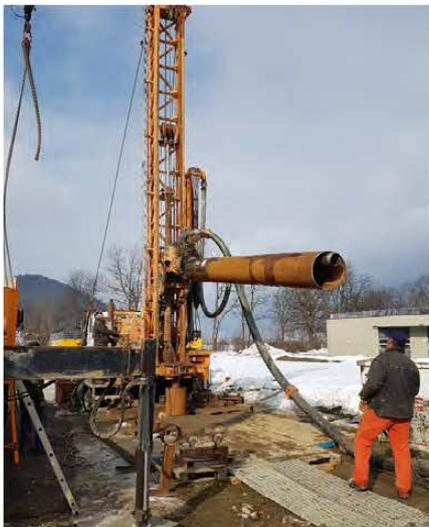
Stahlrohr DN 500, Doppelwandgestänge für
