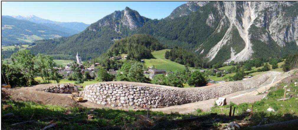
**Abb. 9:** Fertiggestellter Steinschlagschutzdamm Pürgg.
