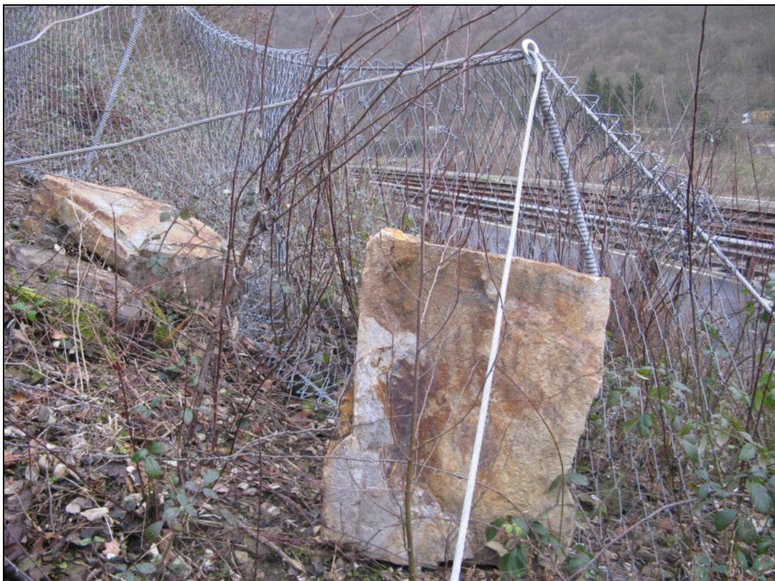
**Abb. 1:** Beispiel eines belasteten Ösenankerzauns oberhalb einer Straße
